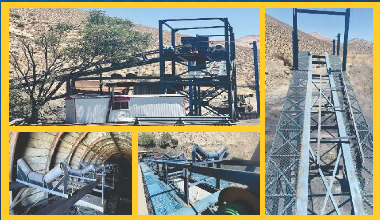
طراحی، ساخت نصب و راه اندازی نوار نقاله ۴۰۰ متری تونل زغال سنگ کرمان - سال ۱۳۹۹
